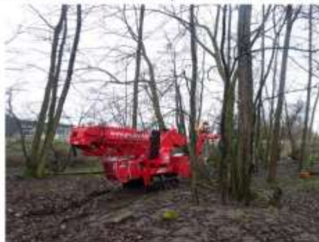
Figure 4 : Nacelle élévatrice utilisée pour accéder aux cavités le 24/02
