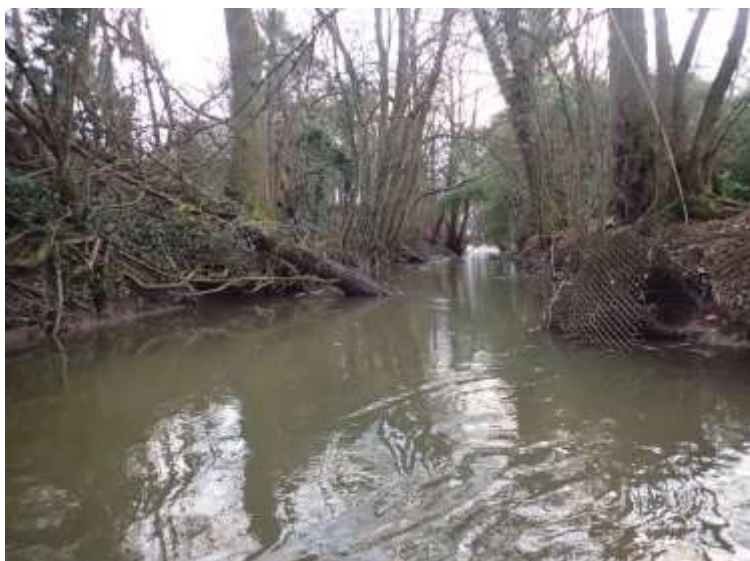
Figure 34 : Bras de décharge du moulin à l'aval du seuil d'alimentation de l'étang de Weyersheim le 15/01/2020
