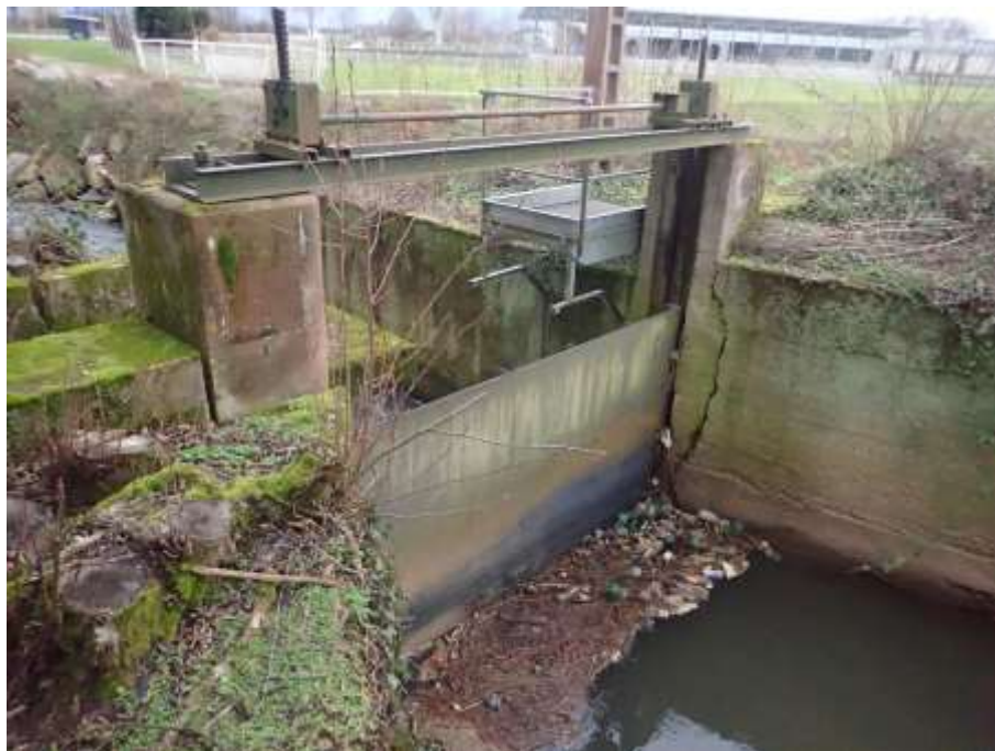
Figure 7 : Vannage du bras de décharge du moulin
