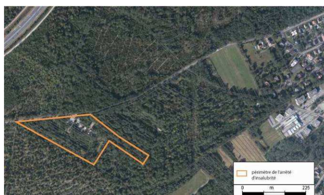
Photo n°9 : Localisation du périmètre d'insalubrité route de Wintershouse
