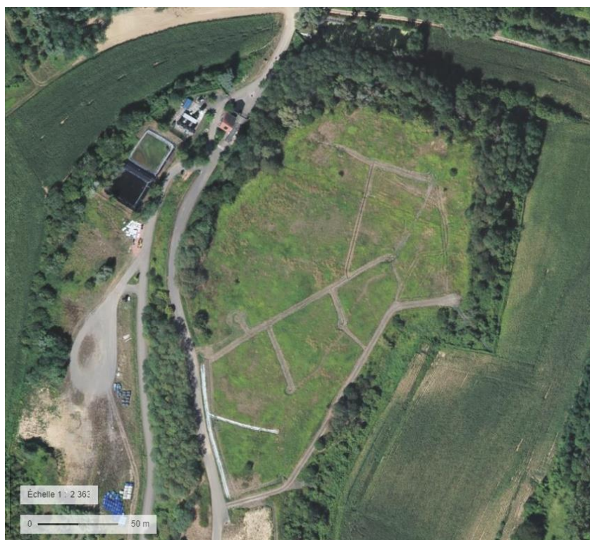
Vue sur le Site Sud de la centrale photovoltaïque projetée (état 2018)
