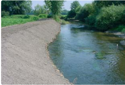
Stabilisation des berges par fascinage : technique végétale douce alliant pieux en bois, fagots et fibre de coco tissée - Service rivière - CG67
