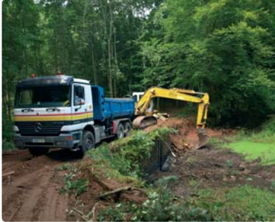
Suppression d'une digue d'étang en barrage sur une rivière de première catégorie
