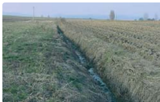
Fossé de drainage en zone agricole - Service Rivières du CG67
