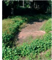
Bassin paysager de décantation des sables en bord de route forestière
