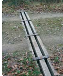
Rigole de dispersion des écoulements sur chemin cammionnable afin de limiter l'érosion
