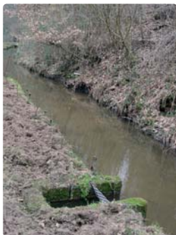
Canal d'alimentation des étangs et prise d'eau latérale
