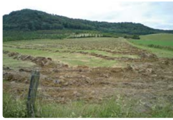
Pose de drains agricoles en zone humide*
