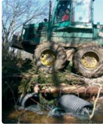
Dispositif temporaire de franchissement en tube PEHD
