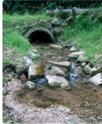
Réaménagement d'une buse pour favoriser la continuité écologique*
