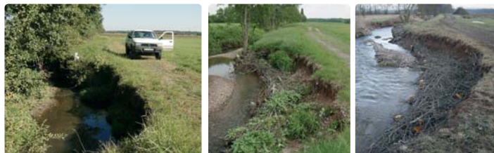
Stabilisation par un « peigne » d'une berge subissant une forte érosion.
