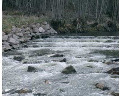
Exemple de passe à poissons constituée de bassins successifs en enrochements
