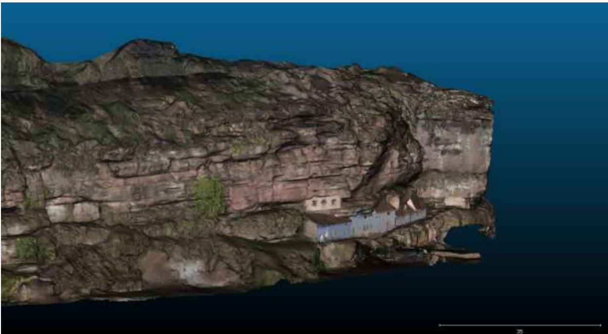
Illustration 18 : Nuage de points texturé de la falaise nord, obtenu à l'aide du LiDAR et des ortho photos
