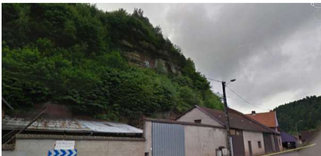
Illustration 49 : Vue d'ensemble du secteur 2 (© Google Earth)
