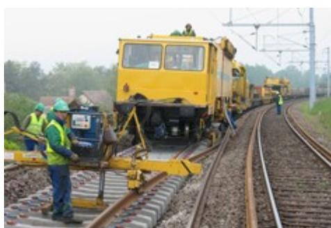
*Longs Rails soudés sur traverses béton*
