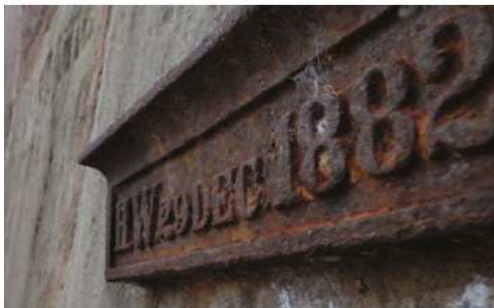
Strasbourg, pont Saint-Martin les lettres HW pour Hochwasser (crue, en allemand) et la date, 29 décembre 1882.
