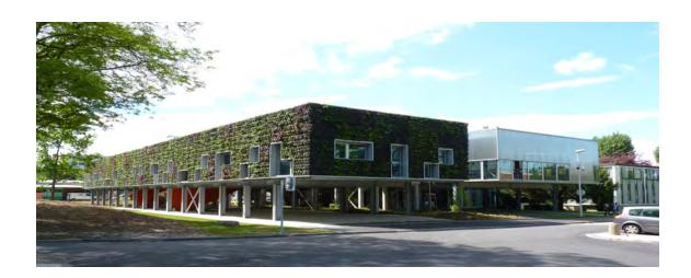
L'espace ouvert entre les deux bâtiments, d'une largeur de 4 mètres, présente l'intérêt pour l'extension existante, de conserver les vues et fenêtres des salles, mais également les apports de lumière naturelle. Pour la nouvelle extension, cette faille permet d'apporter des échappées visuelles pour les nouvelles salles et de favoriser l'éclairage naturel pour la façade non ensoleillée, sans générer d'apports solaires en été.
