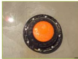
FLO-PLUG® 2 avec rehausse sur géomembrane + remblai
