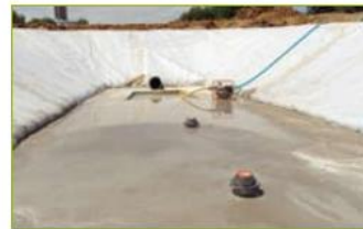
FLO-PLUG® 2 avec rehausse sur géomembrane + remblai
