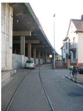
Habitat en immédiate proximité à Schiltigheim
