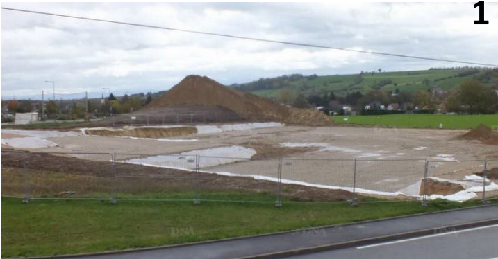
Travaux de terrassement du futur complexe sportif de Val de Moder
