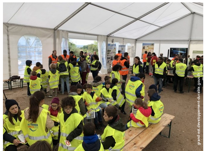
Le 11 et 12 octobre 2019, journées portes ouvertes au public sur le chantier de la rocade Sud.
